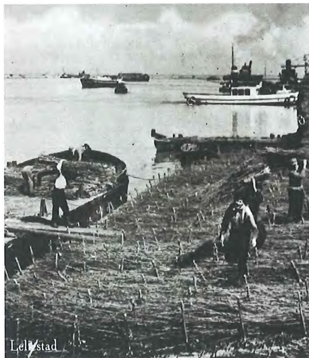
dijkwerkers aan het werk
